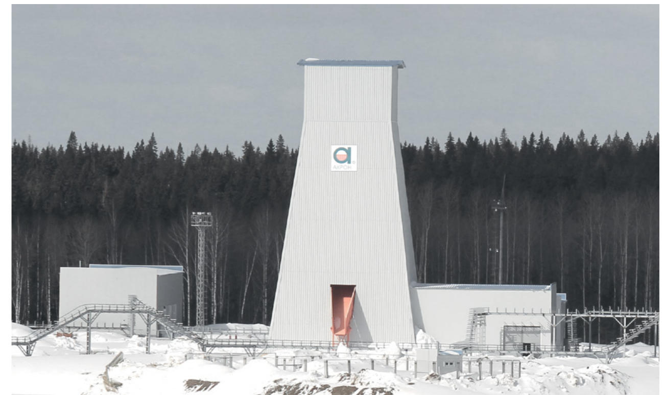
Строительство Талицкого ГОКа
